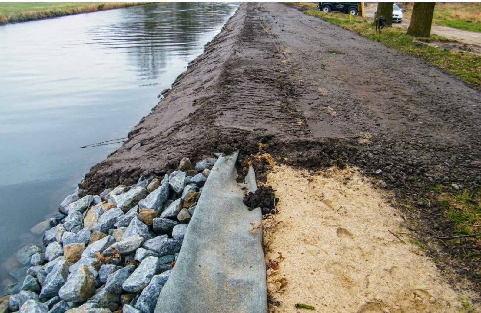
ILUSTRACJA Ułożenie kamieni i okrycie korony grobli piaskiem z humusem, względnie szutrem i murawą.
