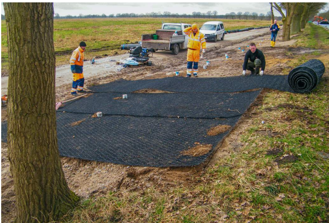
ILUSTRACJA Zakładanie siatki ochronnej przeciwko zwierzętom kopiącym jamy.
