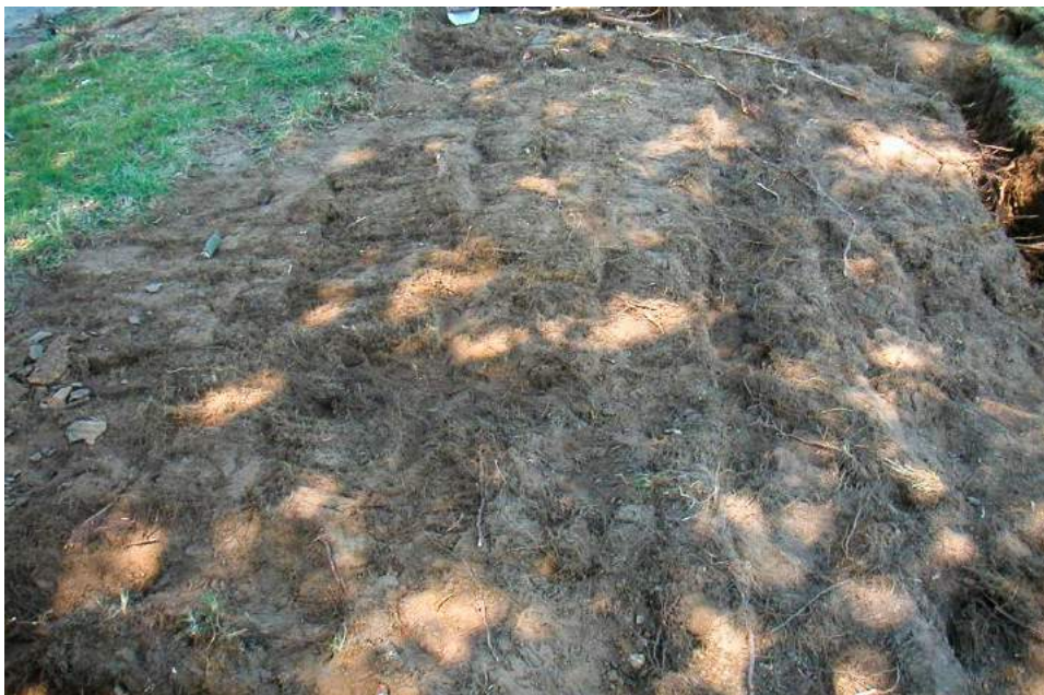
ILUSTRACJA pokazują gęsty system drobnych korzeni kasztanowca pod trawą, przez którą nie można się przebić nawet przy pomocy aparatu podającego wodę pod ciśnieniem. System korzeniowy jak worek trzyma mieszaninę ziemi i piasku, z których zbudowany jest wał, stabilizuje statykę w przypadku przemoczenia i zapobiega wymywaniu materiału wału. (WESSOLLY 2002).
