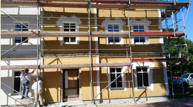
**Wärmedämm Verbund System
