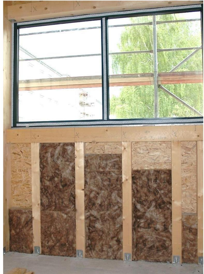
Abb.39-40 Außen- und Innenansicht auf die Außenwandkonstruktion des Ergänzungsbaus Nors(ost)
