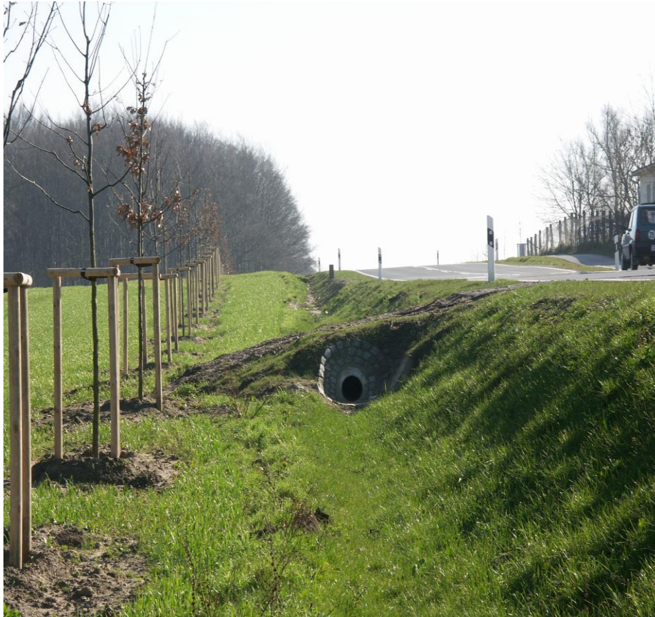
Neuanpflanzung einer Baumreihe auf dem Acker, ca. 7 m Abstand zur befestigten Fahrbahnkante der L13.
