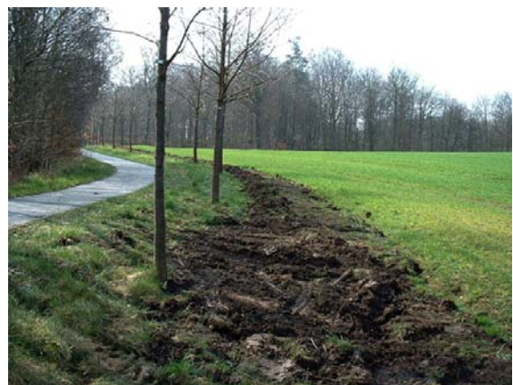
B 110 (Sanitz-Tessin): Kabelverlegung der Bundeswehr im Kronentraufbereich der Jungbäume. Noch immer ist den staatlichen Organen wie der Bundeswehr und der Bereitschaftspolizei schwer zu vermitteln, daß sie materiell an das Landesrecht gebunden sind.
