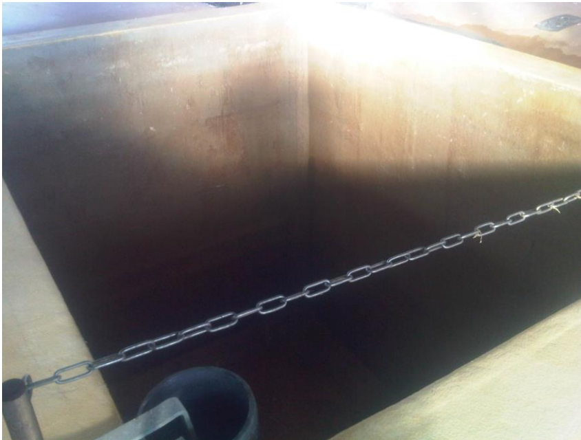
Leeres Sauerkrautsilo, Fassungsvermögen 20t Weißkohl
