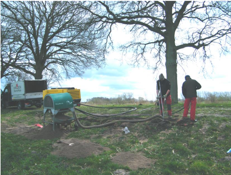
Foto 7: Sauggerät im Einsatz
