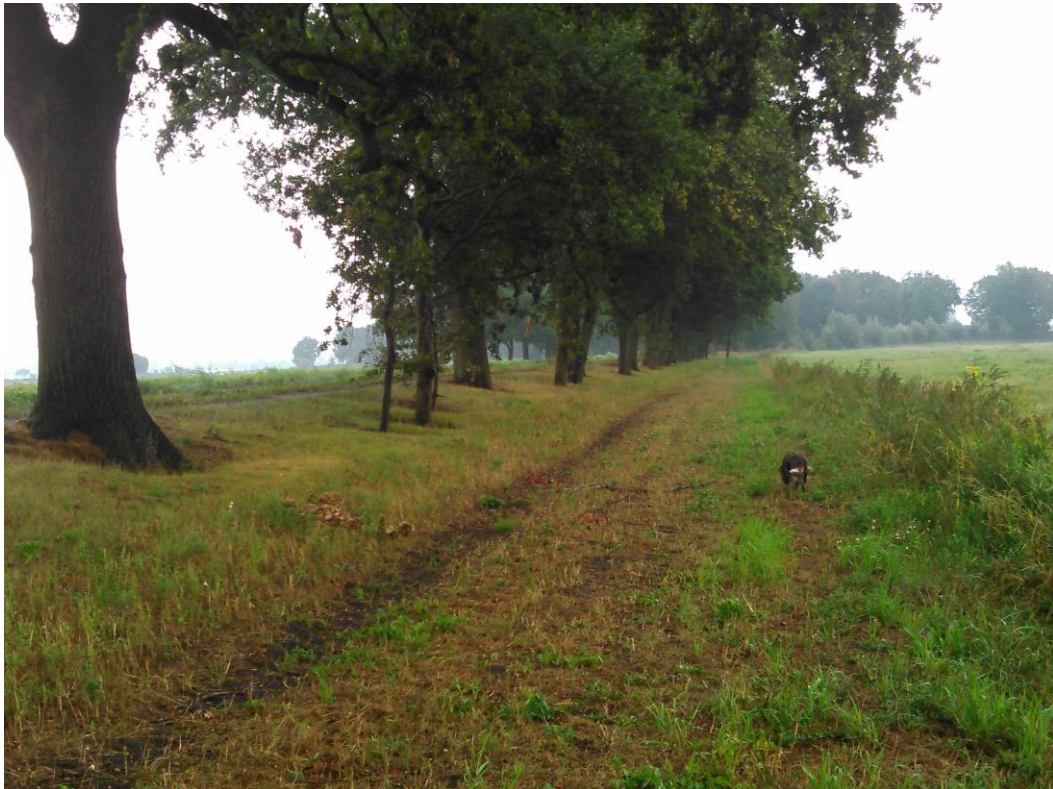
Foto 15: Blick auf den Bereich der ehemaligen Baustraße und die durch den seitlichen Auflastfilter stabilisierte Dammböschung mit der südlichen Eichenreihe im August 2018.
