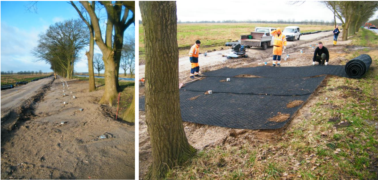
Foto 11 links: Ansicht der Anfüllung mit eingebauten Baumlüftern, links die provisorische Baustraße Foto 12 rechts: Aufbringen des Wühltierschutzgitters
