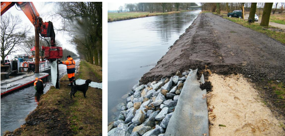
Foto 13 links: Einrütteln des Vlieses mit Spezialgerät Foto 14 rechts: Einbau von Wasserbausteinen und Abdecken der Dammkrone mit humosem Sand bzw. Magerrasenschotter
