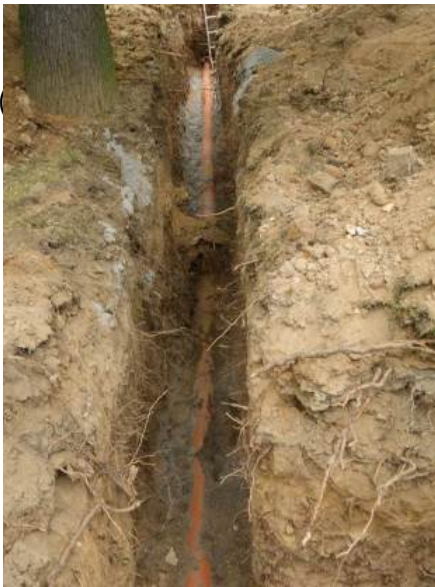
Abb. 5: Erneuerung Hausanschluss im Wurzelbereich einer Eiche
