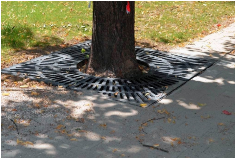
(Abb. 1: Baumumfeld nach Sanierungsarbeiten ohne Hinweis auf mögliche Schäden)
