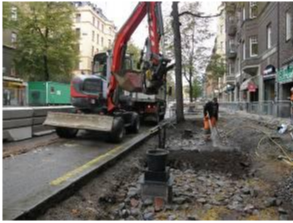
Abb. 8: Einschlämmen von Feinkorb in die Lage aus Grobkorn 100 – 150 mm
