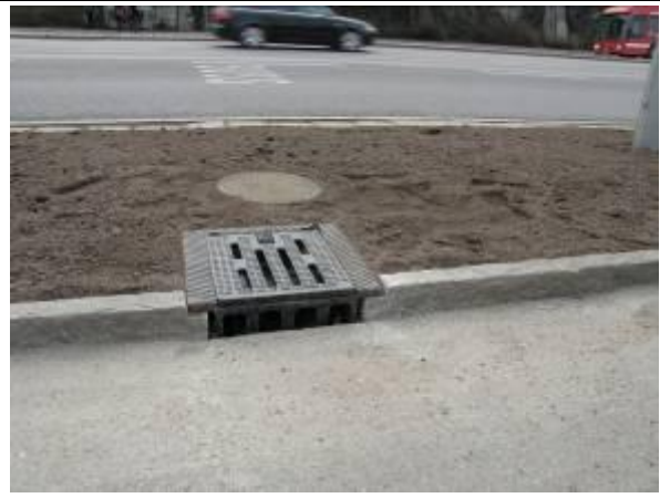
Abb. 13: Nutzung des Regenwassers von Geh- und Fahrradwegen: Straßeneinlauf nach Herstellung der Oberflächen
