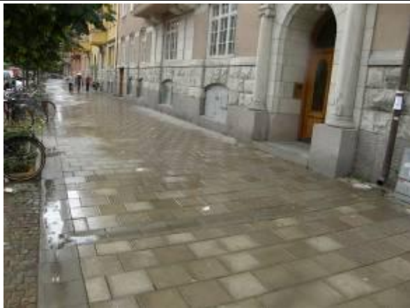
Abb. 10: Nutzung von Regenwasser der Dachentwässerung zur Bewässerung
