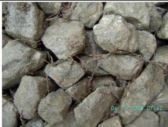
Abb. 14: Wurzelwachstum in den Grobporen der Packlage mit Korngrößen 100 bis 150 mm.
