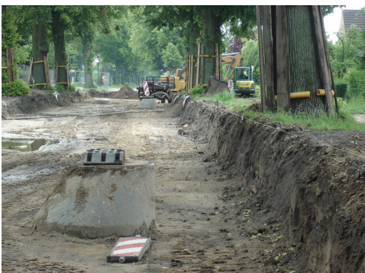
Die meisten Wurzeln befinden sich bis zu einer Tiefe von 60cm. Durch das Bauen im Wurzelbereich wird häufig den Bäumen großer Schaden zugefügt. Nach der richterlich anerkannten Methode Koch entsteht ab einem Verlust von 40% der Baumwurzeln ein Totalschaden an dem Baum.
